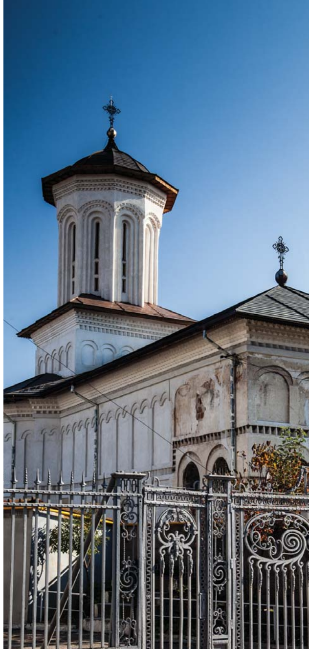
Biserica văzută dinspre nord-vest, din strada Ion Heliade Rădulescu.
