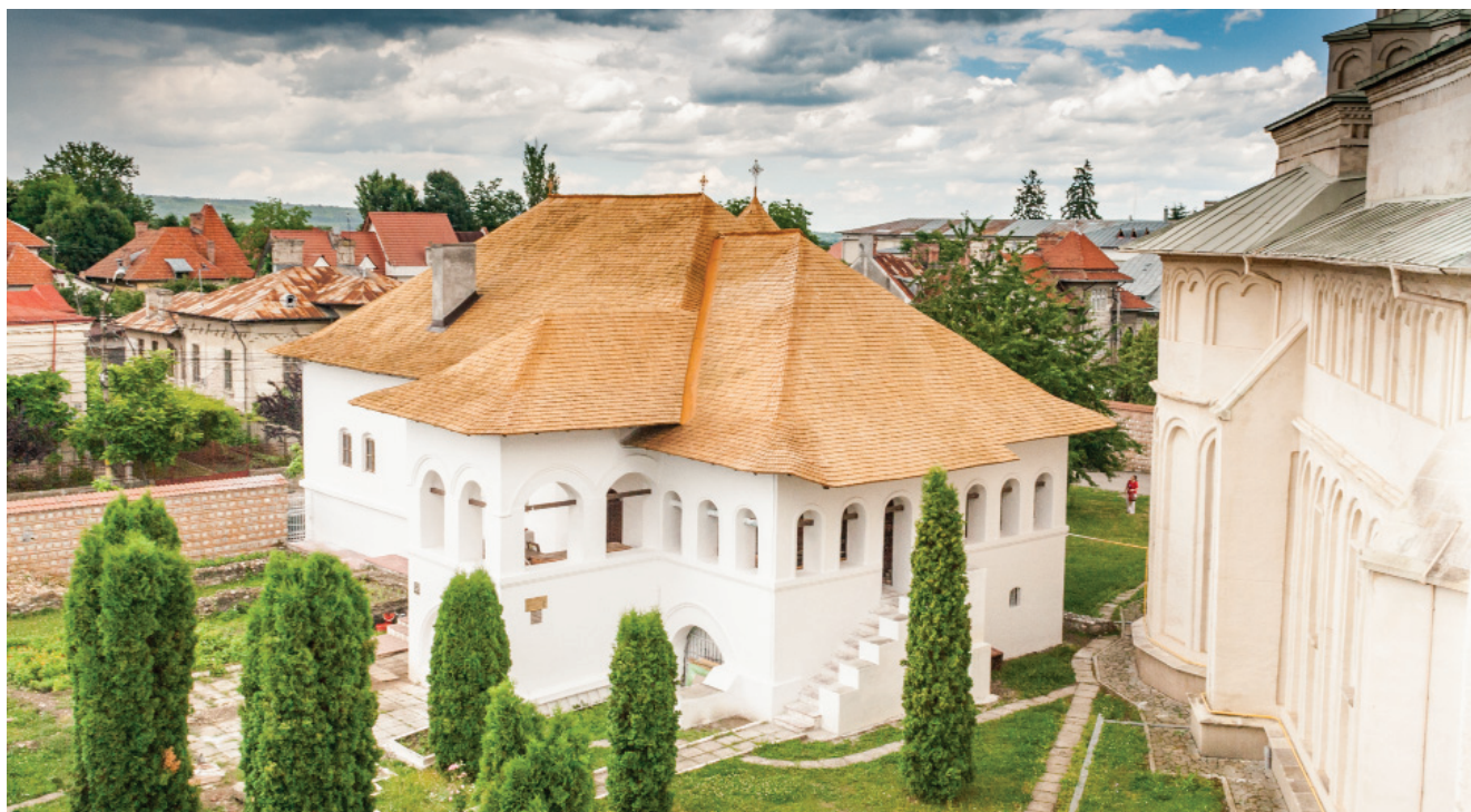
Casa egumenească (Nifon) văzută dinspre nord-vest, din turnul clopotniță.
