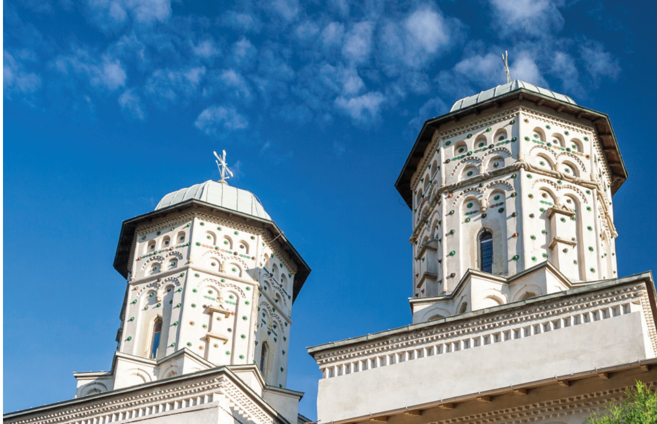
Detaliu al celor două turlă văzute dinspre nord.
